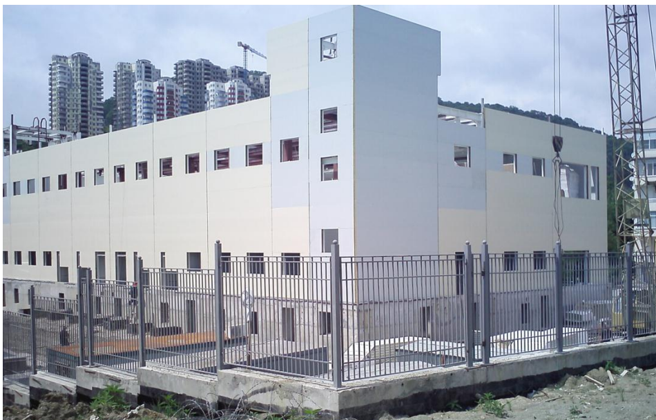
Общий вид подстанции
