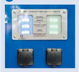
Инновационные зарядные установки «МРСК Центра» могут одновременно заряжать до 2 электромобилей. Время полной зарядки аккумулятора составляет 60 минут без перерывов в электроснабжении потребителей.
