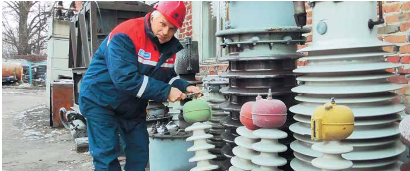
Владимир Кирпичников, электрослесарь по ремонту оборудования распределительных устройств Южного участка службы подстанций управления высоковольтных сетей «Курскэнерго»:
