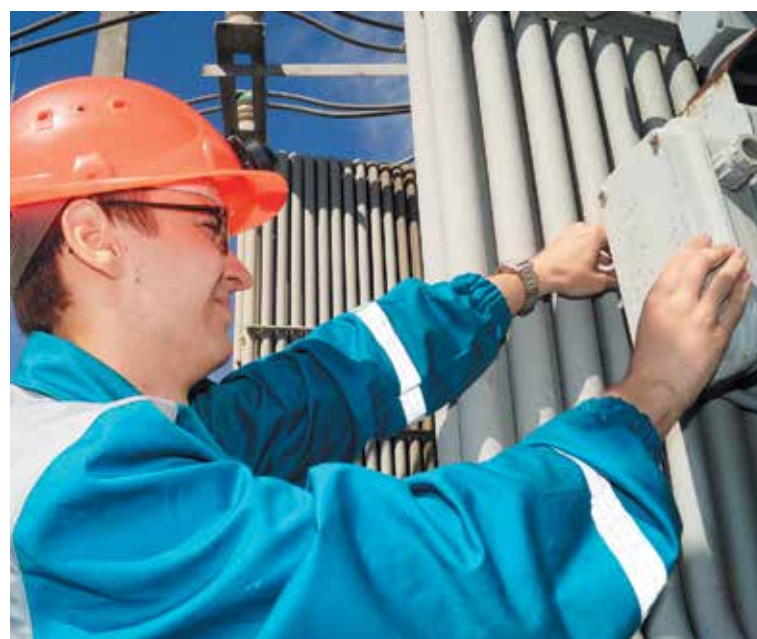
Замена предохранителей на силовом трансформаторе. Работает стройотрядовец Сергей Агибалов
