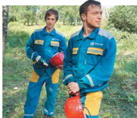
Деревня Михновка. Студенты НИУ «МЭИ» в Смоленске Влад Гамагин и Андрей Макаров расчищают площадку для строительства КТП
