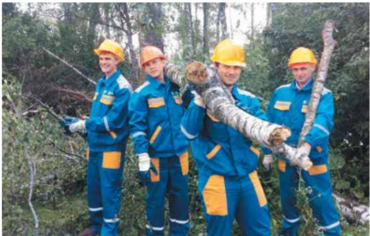
Стройотрядовцы на расчистке просек в Орловском РЭС
