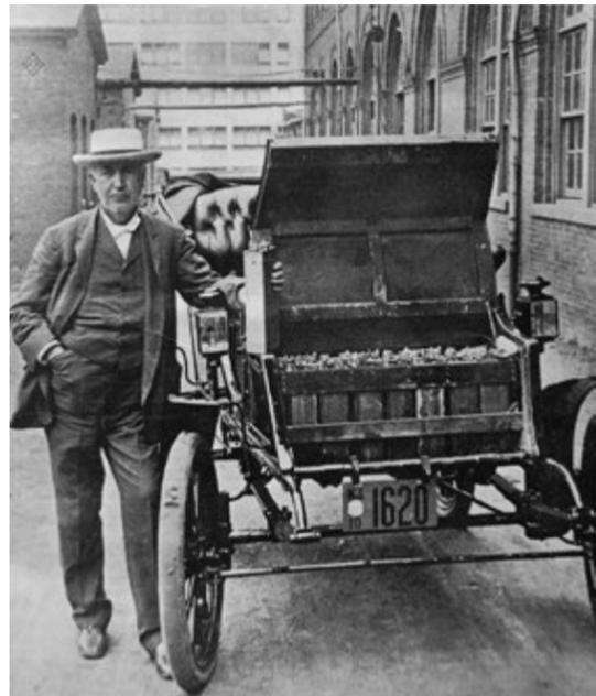
Томас Эдисон демонстрирует железно-никелевые аккумуляторы, расположенные под передним сиденьем одного из первых электромобилей Baker Electric car (начало 1900-х)
