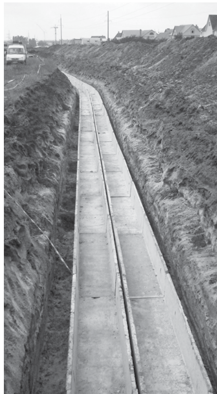
Для защиты от механических повреждений кабель в траншею укладывается в железобетонные лотки и закрывается железобетонными плитами
