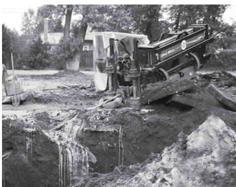
Строительство линий осуществляется с применением горизонтального направленного бурения
