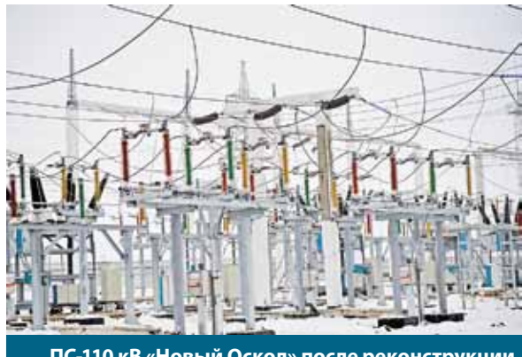
ПС-110 кВ «Новый Оскол» после реконструкции
