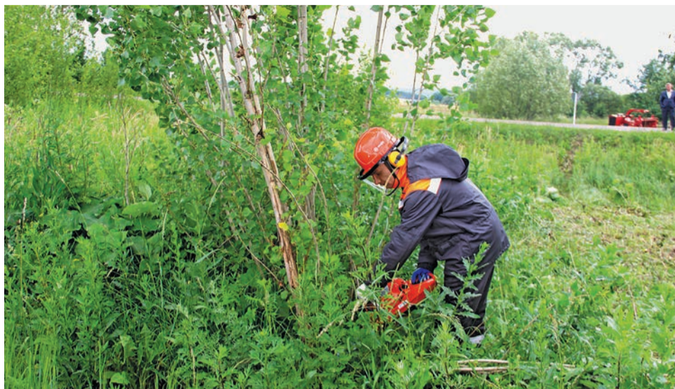
Расчистка просек в Орелэнерго
