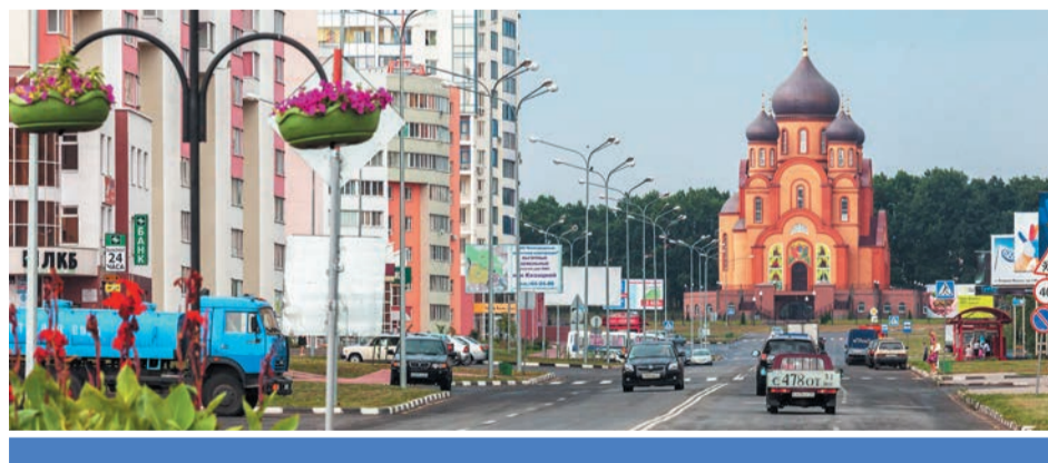
Подстанции городского кольца в Старом Осколе обеспечивают электроэнергией более 160 тысяч жителей
