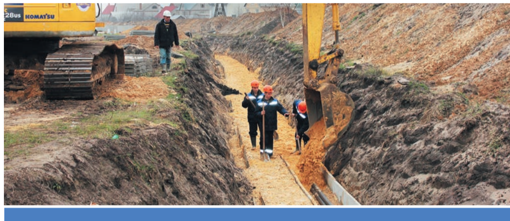
Прокладка кабельной линии от подстанции «Подгорное» до подстанции «ВПИ»
