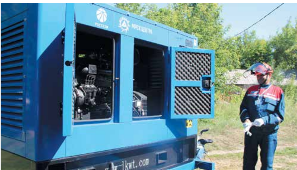
Мобильная бригада «Брянскэнерго» была оснащена всем необходимым оборудованием
